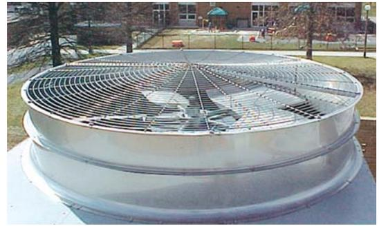
Disponible en los modelos de 3,6 m de ancho de Torres Abiertas AT, Torres Cerradas ATW y ESW, y Condensadores Evaporativos ATC.
