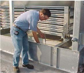
disponen de tiradores para retirarlos. Una vez retirados, se tiene total acceso a la bandeja de agua, batería de transferencia de calor, válvula de flotador y filtro de la bomba.
